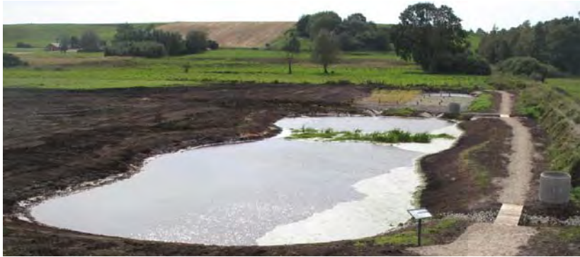
Minivådområde anlagt af Hedeselskabet ved Ondrup Mose, Odder. Forbassin foran i billedet, biofilter og efterklaringsbassin i baggrunden.
