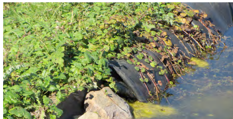
Kant af folie på en lægte. Kanten skjules af planter, som vokser hen over den.
